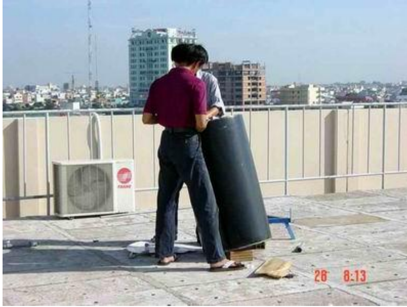
Lắp đặt thùng nước nóng sử dụng năng lượng mặt trời kiểu ống trụ đứng
